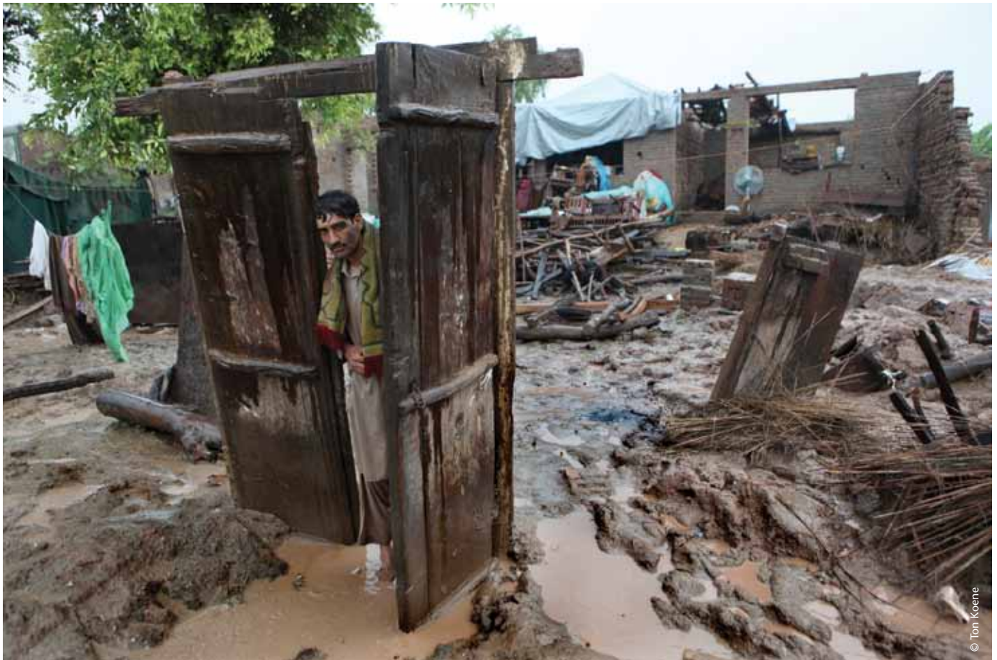
Dégâts provoqués par les inondations à Gulabad, Pakistan.
